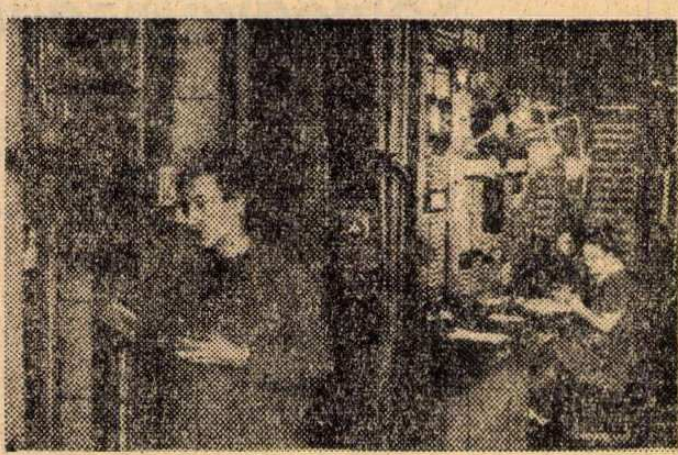
A régi központban — a 12/A soron a szembeforgó gépek közötti távolság még 58 cm volt, ami kényelmetlen és veszélyes is.
